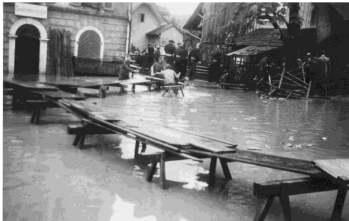
Überflutung Dorfstrasse Oensingen beim Schulhaus Unterdorf 1939
